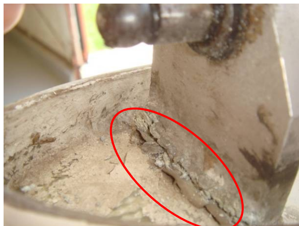
Fig. / Abb. 3 Flaking Abplatzungen
